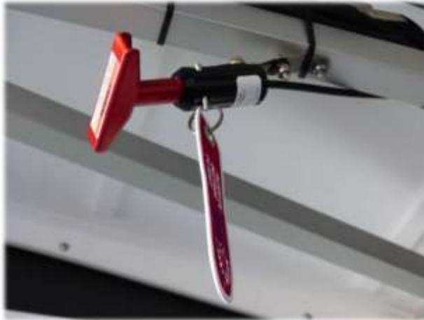
Abbildung 7: Auslösegriff mit Sicherheitspin
